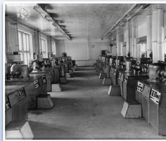
Цех по производству лейкосапфира
